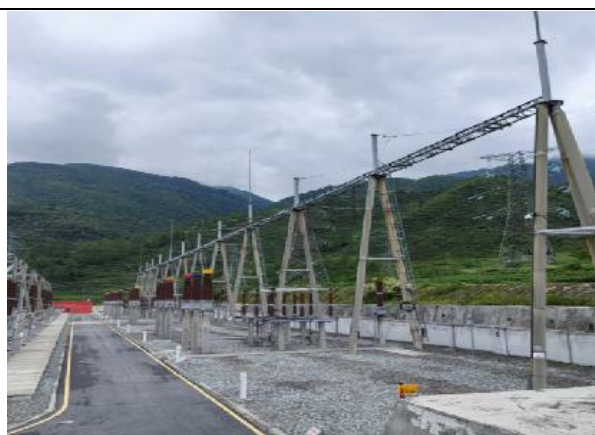
既有 220kV 配电装置及出线间隔
