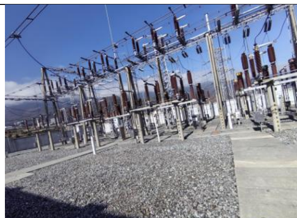
既有 110kV 配电装置及出线间隔
